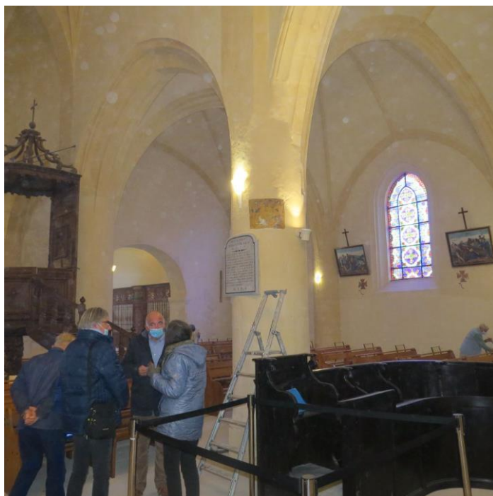
Fig. 1 : Ars-en-Ré, église Saint-Étienne, vue partielle du chœur vers le nord-ouest. Situation du fragment peint à étudier au 27 octobre 2020.
